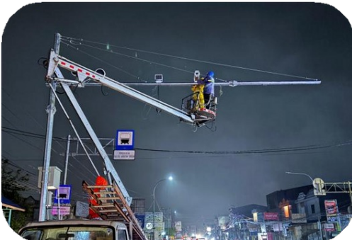
Pemasangan Kamera ETLE di Gowa
