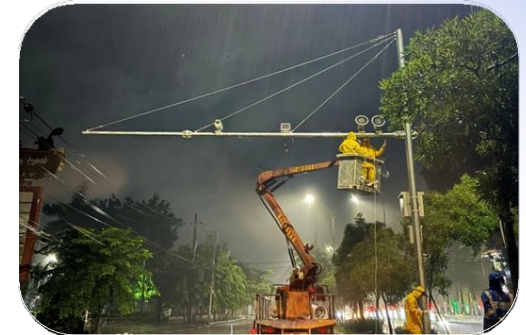
Pemasangan Kamera ETLE di Makassar
